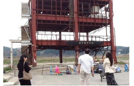
南三陸町の防災庁舎を見上げるメンバー
